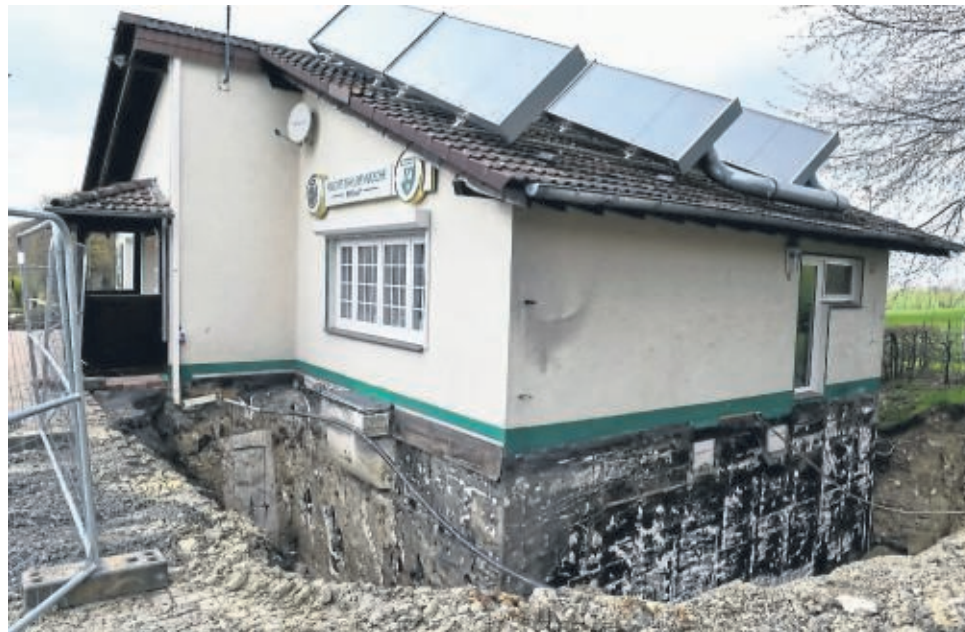
Das komplette Kellergeschoss mit den Kabinen und Duschen wird renoviert.
