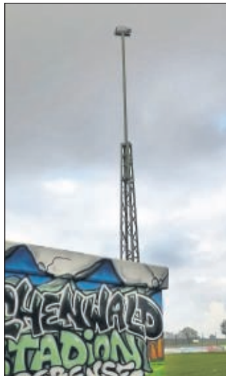
Die Standsicherheit der Masten ist gegeben. ■ Foto: Stute
